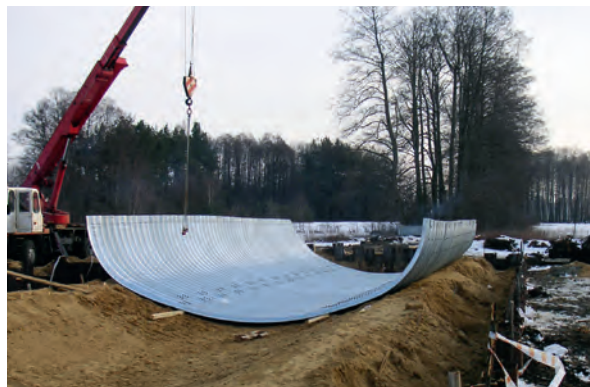
Fig. 11. Prinderea structurii SuperCor® pe o fundație flexibilă
