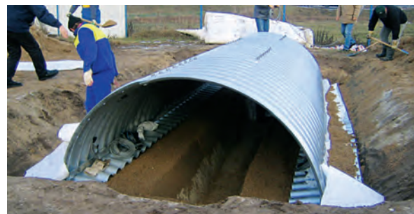
Fig. 3. Montarea structurii MultiPlate MP200 pe fundație flexibilă
