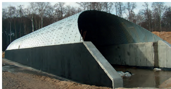
Fig. 2. Montarea structurii MultiPlate MP200 pe fundație din beton
